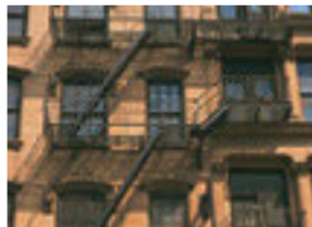
la salida de incendios požarne stepenice
